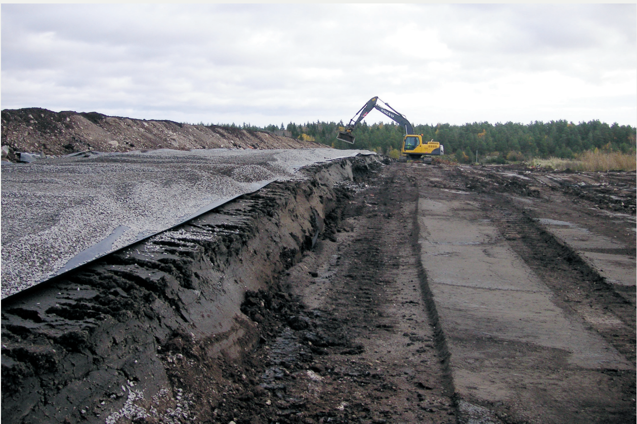
Utläggning av tätskikt bestående av flygaskestabiliserat avloppsslam och dränering på en deponi i Eskilstuna.
